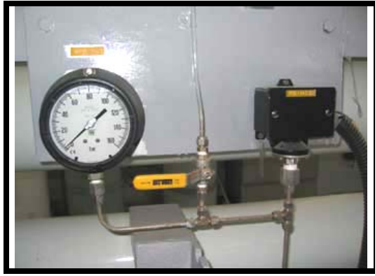
شكل (١١-٨) صورة لعداد قياس ضغط طرد مضخة الضغط العالي
